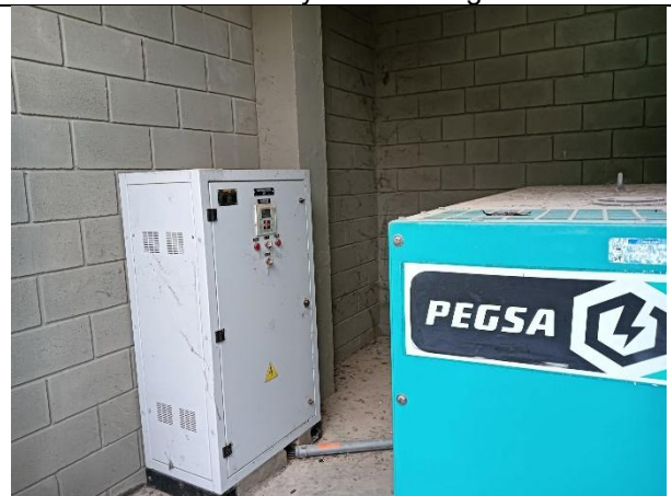
Foto 18. Planta electrica de emergencia sub utilizada por falta de mantenimiento y desconocimiento de operacion. (a pesar de capacitaciones dadas)
