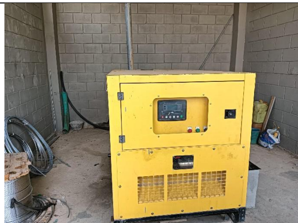
Foto 10. Planta eléctrica de emergencia sub utilizada por falta de mantenimiento y desconocimiento de operación.
