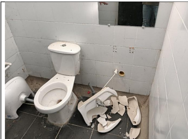
Foto 9. Los chazos de anclaje a muro de las uñas de lavamanos no cumplen con objetivo y se han generado desprendimiento prematuro de estos.
