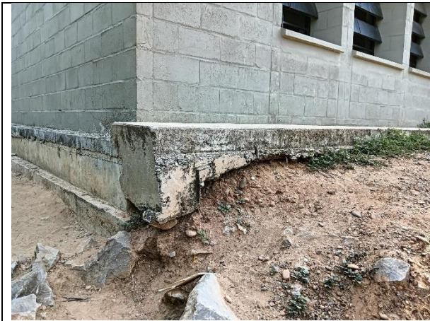
Foto 15. Se presenta socavacion en algunas esquinas del talud de corredores laterales, pero estas no ponen en riesgo la estructura.
