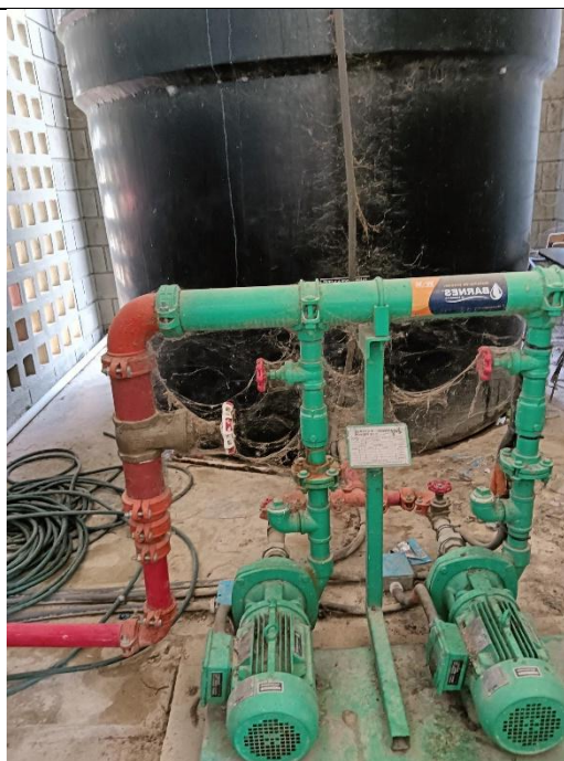
Foto 12. Sistema de Bombeo y tanques de agua consumo y contraincendios, sin uso por desconocimiento de operación de planta eléctrica.
